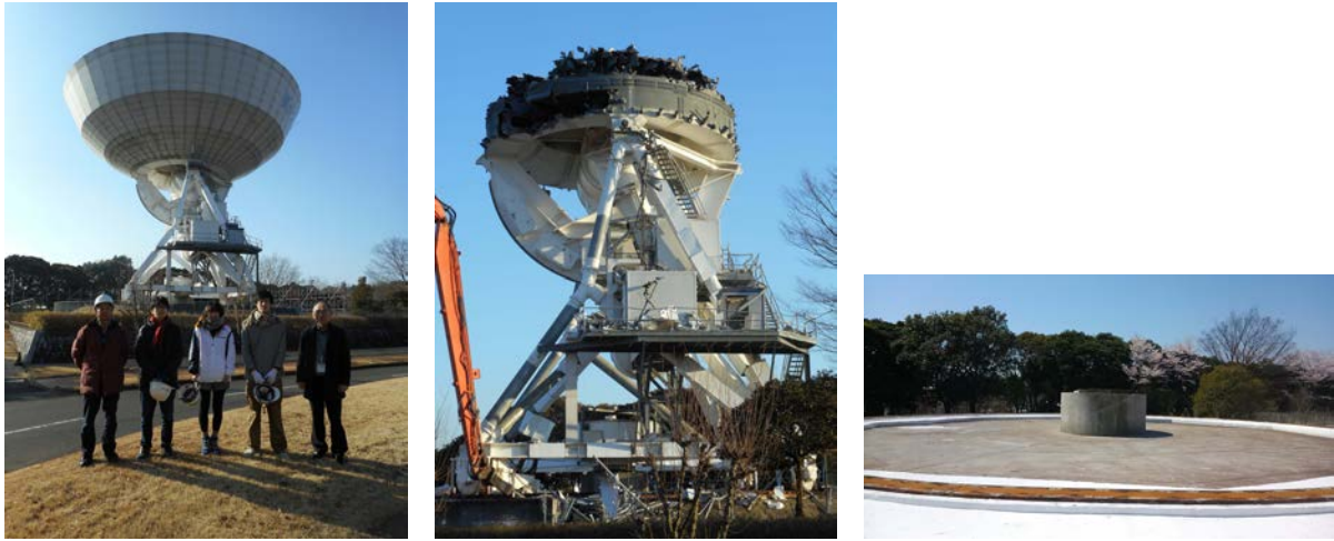
図 20 国土地理院つくば 32m 鏡アンテナ：左から 2017 年 1 月 4 日（解体前日）、1 月 22 日（解体中）、4 月 14 日（解体後）
